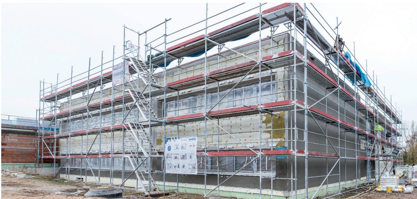
Dämmung und Verputzen der Fassade
