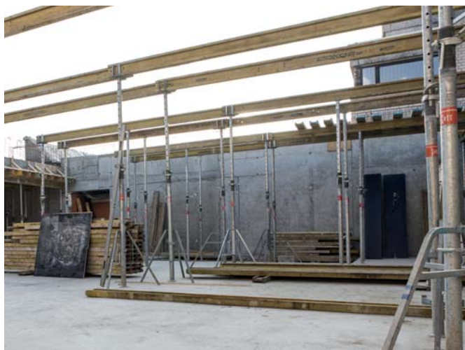
Die Bodenplatte der Pausenhalle wird gegossen
