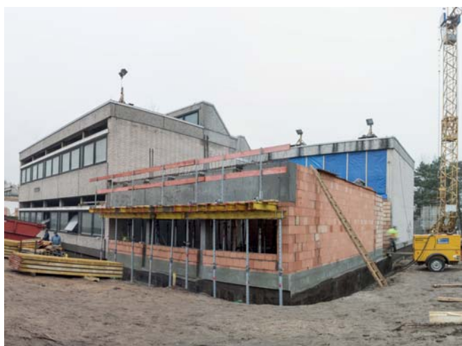
Der neue Grundschulwerkraum
