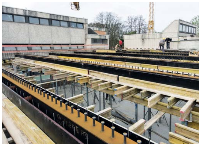
Die Decke der neuen Pausenhalle
