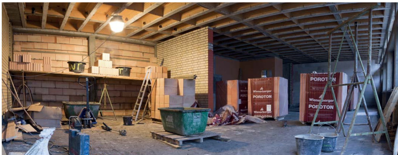
Die neue Schulküche nach dem Rückbau
